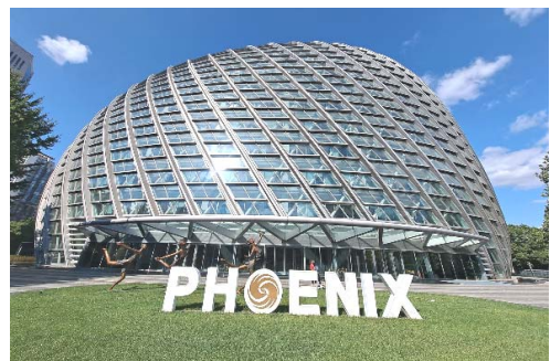
图 1 北京凤凰国际传媒中心采用四边形玻璃面板进行覆层
