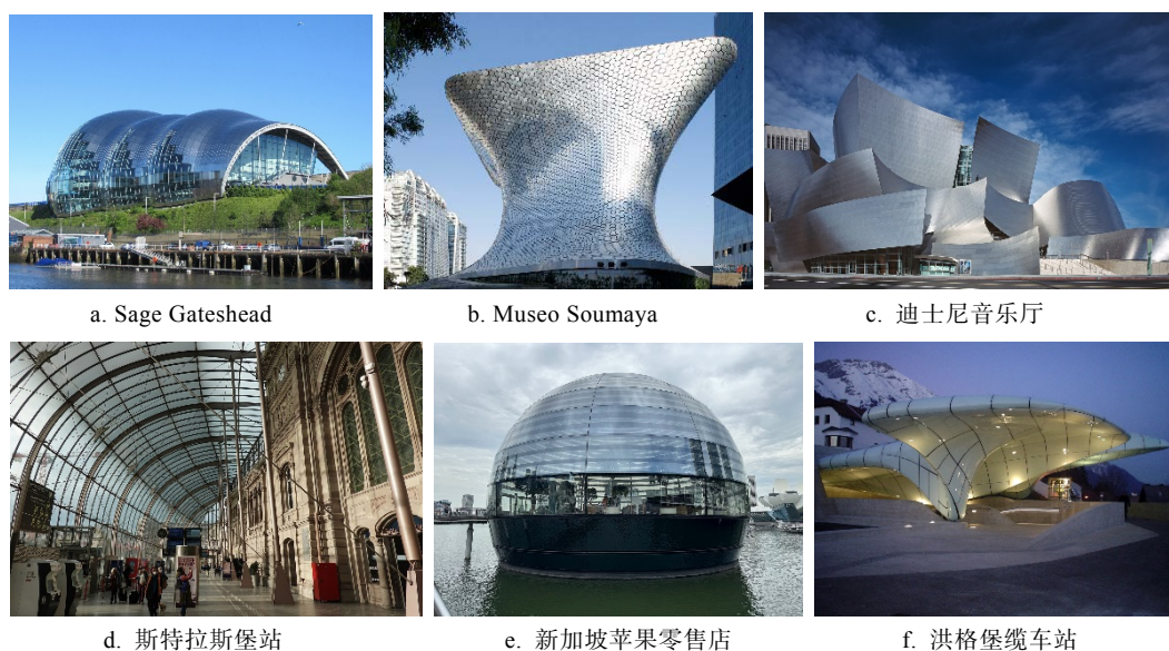
图 7 现代建筑广泛采用面板方式进行覆层
